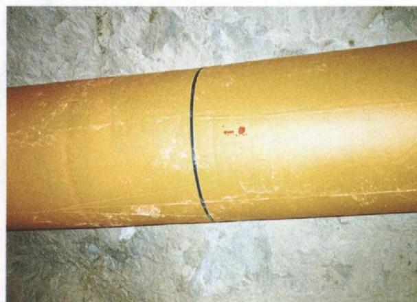
**制電風管** ■帯電防止加工布(絶縁抵抗  $5 \times 10^9 \Omega$  以下)使用 ■実用新案特許申請中 改正JIS相当品
