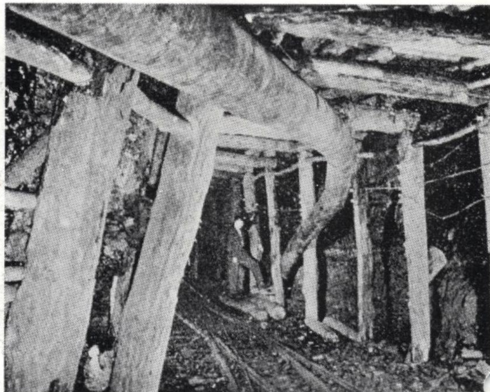
2. 坑内で邪魔にならないで頭上に取付てある
