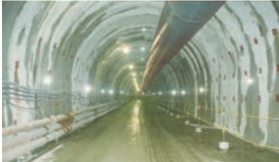
ナトム工法でのファスナー式FST風管実用例
