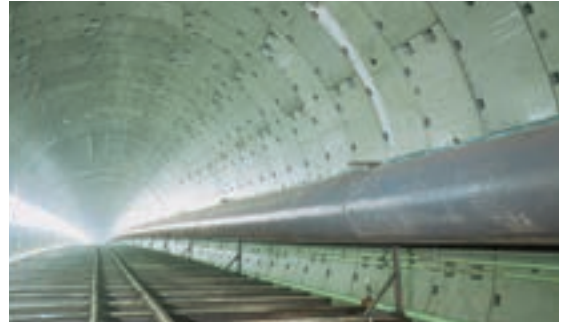
シールド工法でのファスナー式FST風管実用例
