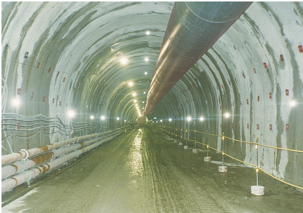
ナトム工法でのファスナー式FST風管実用例
